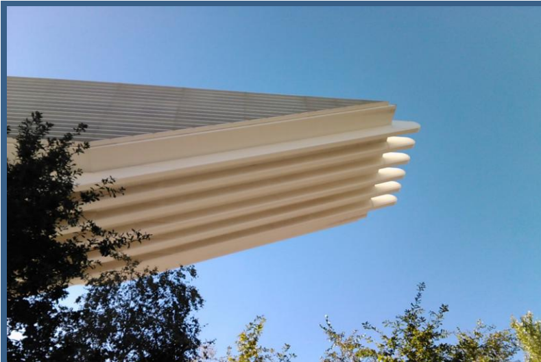
Edificio Buenavista, Oviedo.
